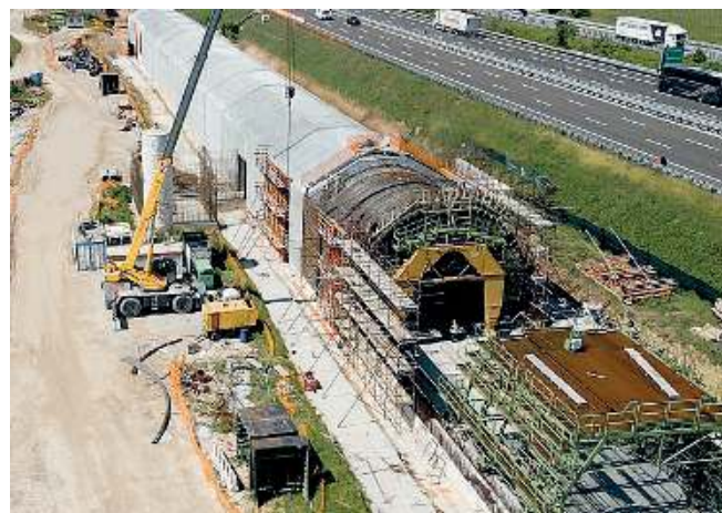
Il cantiere. I lavori sulla linea Brescia-Verona della Tav, a Peschiera
